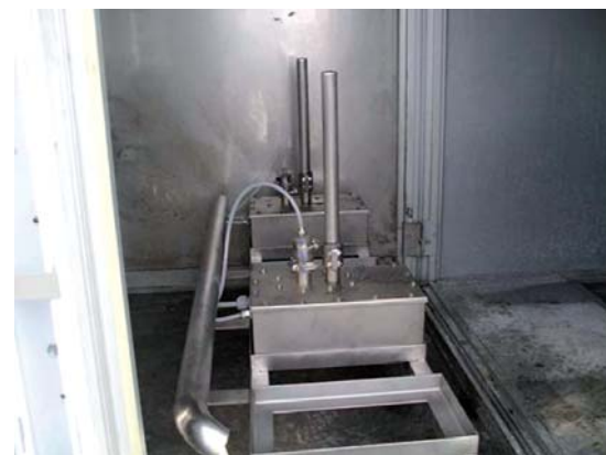
Abb. 3: Integration eines Vernebler-Moduls in einer Lüftungsanlage
