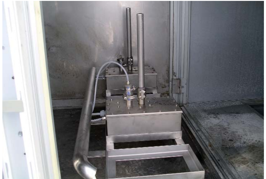
Entkeimungsstation im Zuluftsystem
