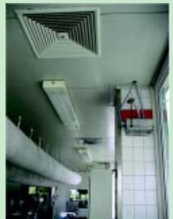
Raumlufthygienemodul in der Feinkostherstellung
