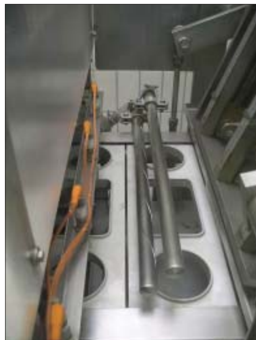
Entkeimungsstation an einem Abfüller
