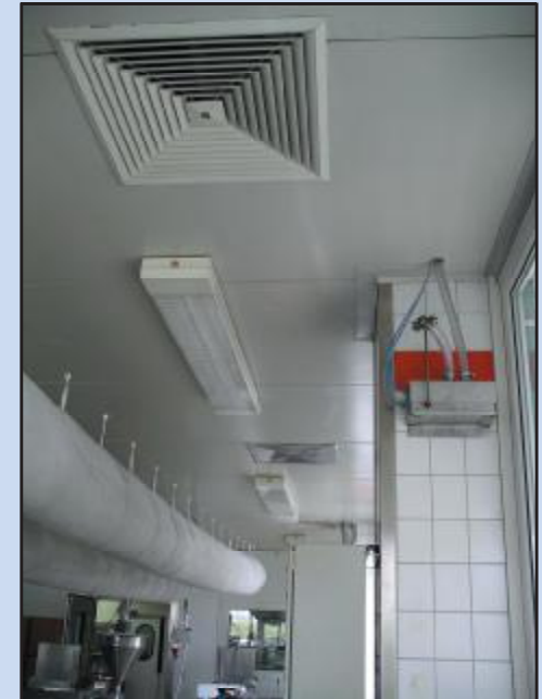
Stoppen die Keime: Raumluftentkeimer AS 400 J (rechts) und Entkeimungsvorrichtung AS Belt Hygenic (oben)
